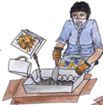
**3.** Si vous utilisez du mortier-colle en poudre, le préparer (en suivant les indications sur le paquet) à l'aide d'une spatule, de façon à obtenir une pâte homogène et sans grumeaux. Une fois le mélange fait, il va se durcir plus ou moins rapidement selon sa composition et les conditions – température, taux d'humidité... Il ne faut donc pas le préparer à l'avance mais lorsqu'on est prête à coller !
