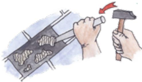
**2.** Faire sauter les résidus de l'ancien mortier-colle à l'aide de la spatule plate rigide ou du burin plat et du maillet. Terminer en passant une brosse (ou l'aspirateur) puis un chiffon humide afin d'enlever toutes les poussières de la surface à encoller et permettre au mortier-colle de bien adhérer. Si l'ancien carrelage est récupérable, nettoyer son dos en enlevant précautionneusement les restes de l'ancien mortier-colle de la même manière.
