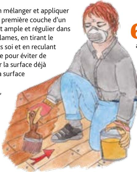
**6.** Après 15 minutes, frotter les surplus d'huile avec le chiffon, d'un geste circulaire et appuyé. C'est important qu'elle pénètre vite et bien les pores du bois, afin d'éviter qu'un film collant ne se forme en séchant en surface. Changer de chiffon dès qu'il devient trop « huileux ».
