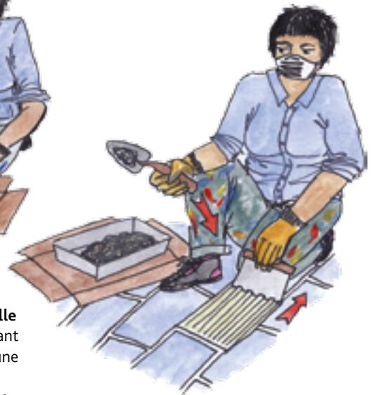
**4.** Déposer la quantité nécessaire de mortier-colle sur le mur/sol et/ou sur le dos du carreau avec la truelle et l'étaler uniformément à la bonne épaisseur à l'aide de la spatule crantée.
